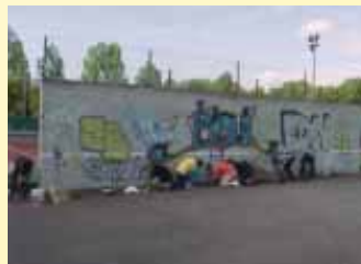
Mise en peinture du mur d'entraînement du tennis à Fléville
