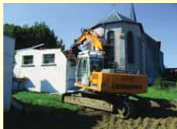
Démolition de la sacristie datant de 1967
