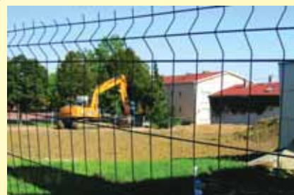
Démolition de la salle des fêtes
