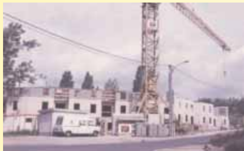
La Résidence du Moulin en construction en 1985.
